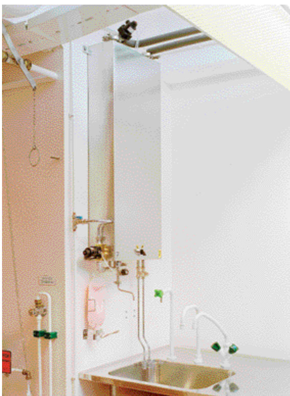
Рис.2. Применение модуля Pharma-X в качестве технологического охладителя на предприятии компании АстраЦенека, в г.Содерталь, Швеция.
